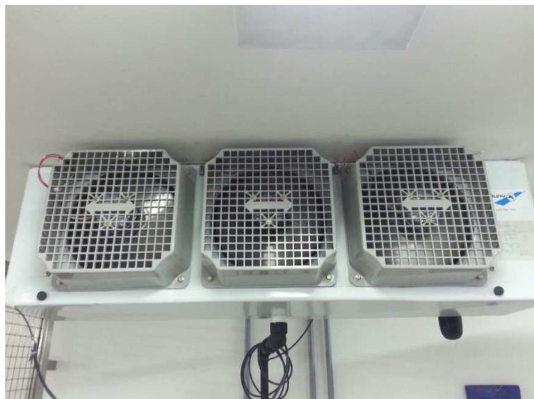
Figura 4-4 Saída de ar refrigerado da sala de *freezer*.
